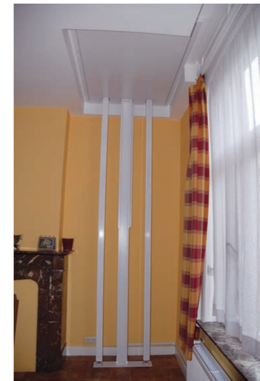
Une nacelle peut maintenir le volume des pièces. L'appareil est renvoyé vers l'étage où on ne se trouve pas, pour gagner un peu de place
