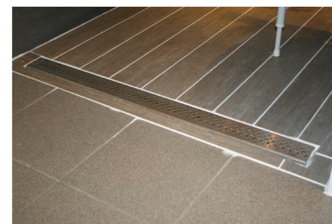
Un accès facile sans rebord à franchir! Le revêtement antidérapant et le caniveau d'évacuation permettent de limiter les risques de glisser
