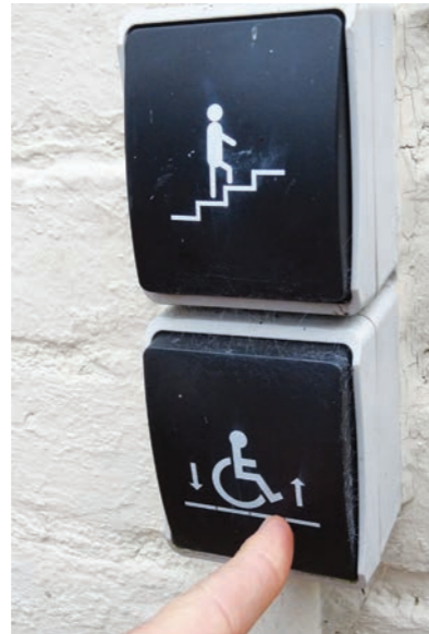
Cette plate-forme élévatrice devient un escalier, ou plutôt cet escalier se transforme en plate-forme élévatrice
