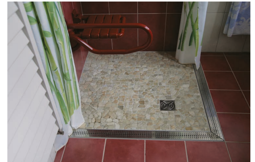
Des "caniveaux" périphériques empêchent l'eau de sortir de l'espace douche.
