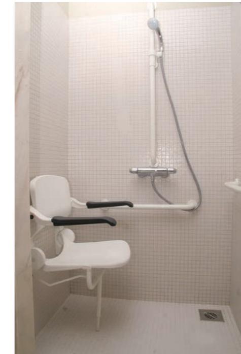
Lorsque la structure du sol ne permet pas d'encaster un receveur de douche, il convient de prévoir un léger plan incliné
