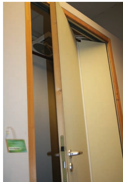
Le modèle elliptique permet de faciliter l'ouverture de porte avec un encombrement réduit
