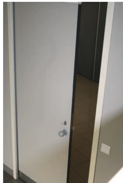
La porte coulissante encastrée dans le mur, discrète et facile à manipuler (possibilité d'installer une ouverture motorisée)
