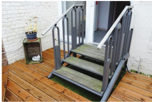
Cette plate-forme élévatrice devient un escalier, ou plutôt cet escalier se transforme en plate-forme élévatrice
