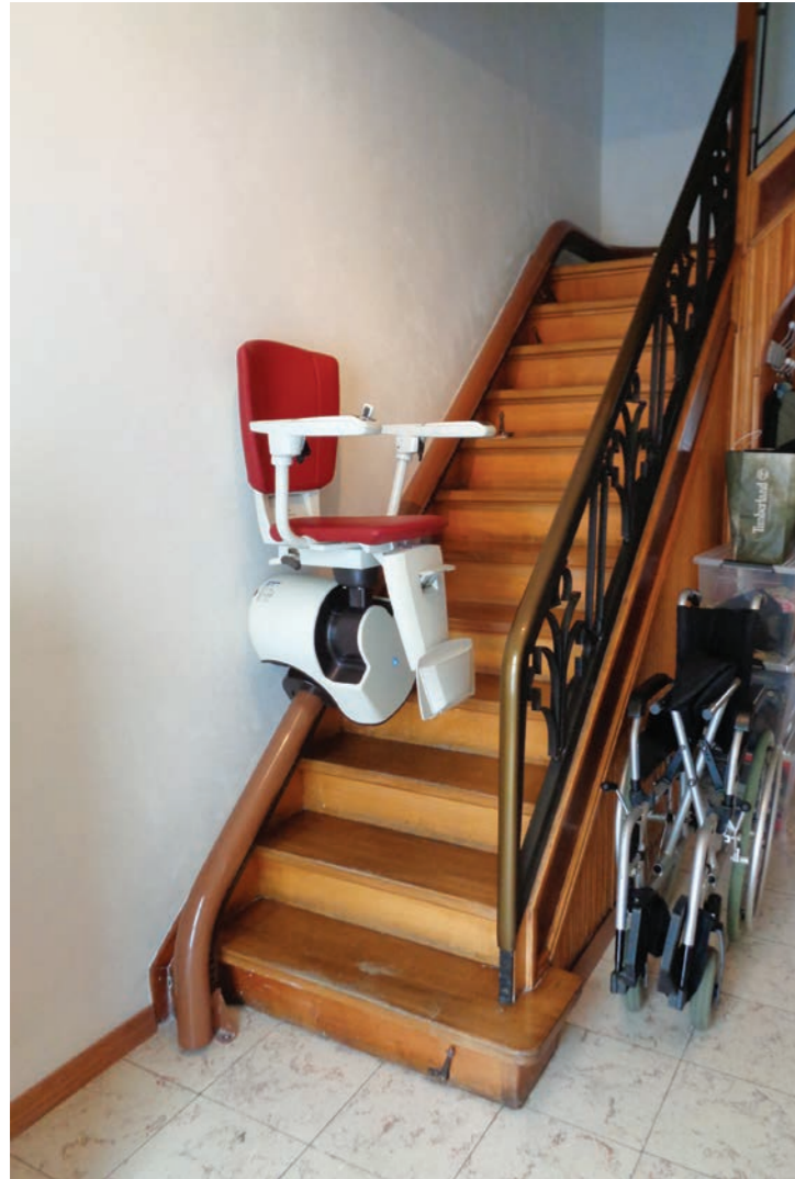
Un monte-personne peut ressembler à un ascenseur. L'encombrement et le coût sont moindres. Il peut se placer dans des locaux existants et ne nécessite pas de fosse technique.
