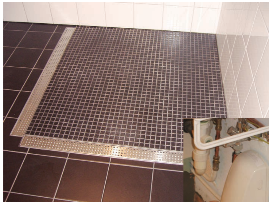
L'évacuation de l'eau se fait dans le fond de la douche. Des caniveaux ou drains périphériques sont INDISPENSABLES pour retenir les débordements d'eau et éviter d'avoir un sol mouillé au dehors de l'espace douche
