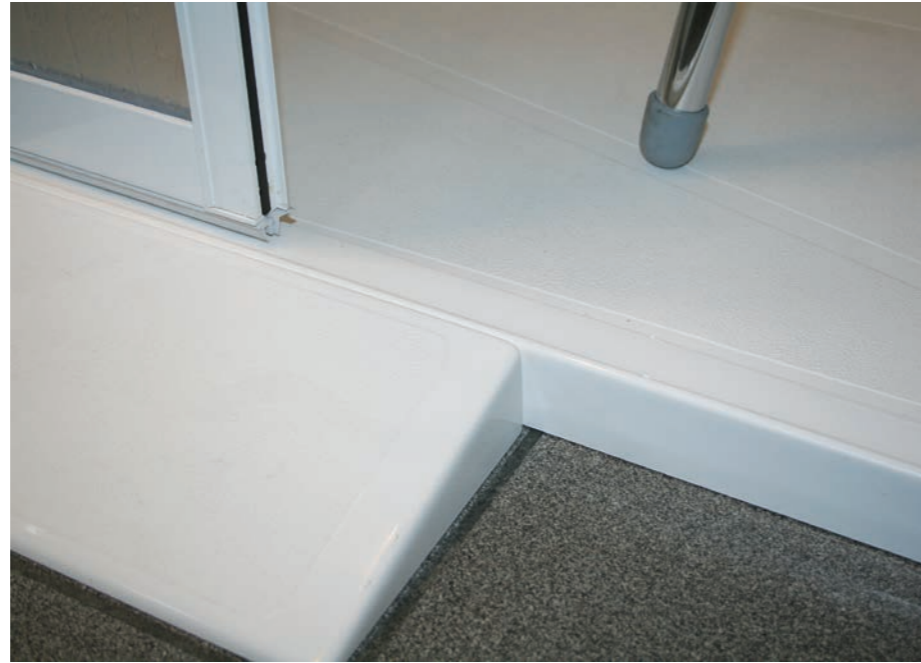
Si le receveur est posé au sol, il est possible de placer un petit plan incliné afin de permettre l'accès en voiturette.
