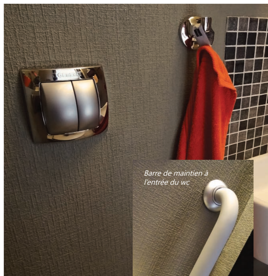
wc suspendu et légèrement rehaussé avec commande de chasse d'eau latérale
